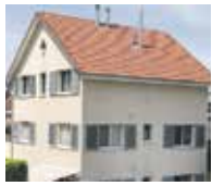
Das Dach circa ein Jahr später.
