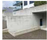
Nachher: Betonstützmauer ca. 1 Jahr später
