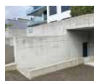
Nachher: Betonstützmauer ca. 1 Jahr später
