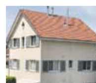
Das Dach circa ein Jahr später.
