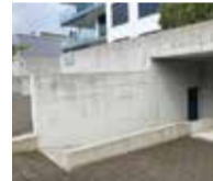
Nachher: Betonstütz-mauer ca. 1 Jahr später
